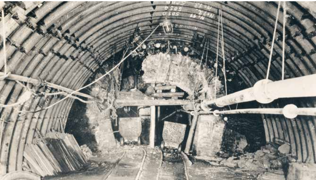
Abbildung 58 Ein eindrucksvolles Bild zeigt „das Mauselloch“, wie die Bergleute es nannten. Man sieht sehr anschaulich die Dimensionen des „alten“ und des „neuen“ Bergbaus. Man kann die Mauerung und den Querschnitt eines früheren Aufschlusses sehen. Das Foto wurde im Verbundbergwerk Gouley-Laurweg gemacht (Kulturarchiv Würselen).
