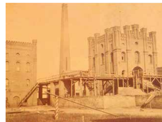
Abbildung 42 Die neue Grube Teut in Schweilbach mit dem Malakowturm um 1880. Später übernahm Gouley die Förderung aus diesem Feld (Kulturarchiv Würselen).
