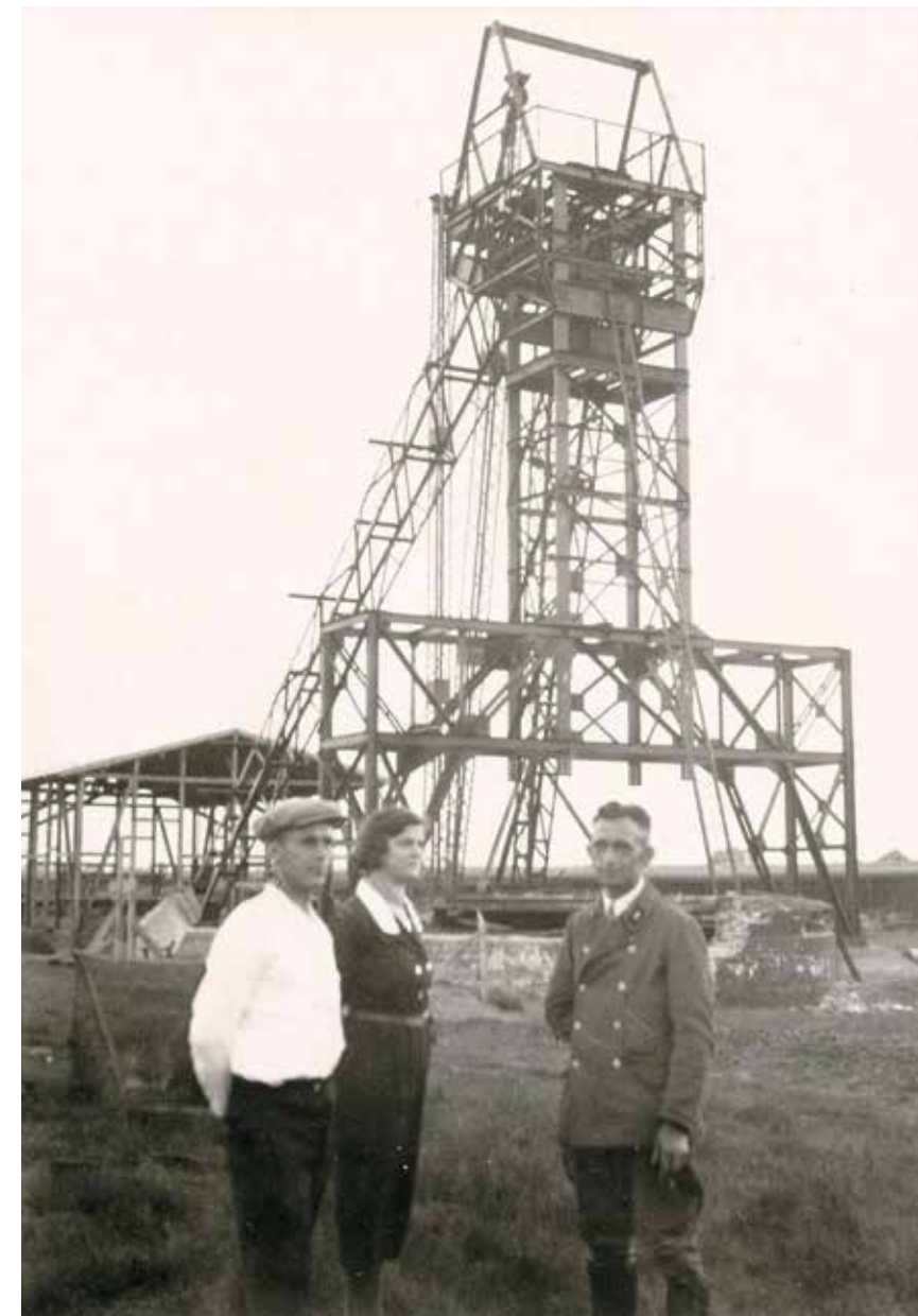
Abbildung 40 Die Abteufung des Schachtes Gemeinschaft im Duffesheider Feld erwies sich als sehr schwierig. Letztlich wurde der Schacht als Wetterschacht genutzt. Das Foto entstand 1934 beim Bau des Schachtgerüsts (Foto: Schultheis; Kulturarchiv Würselen).
