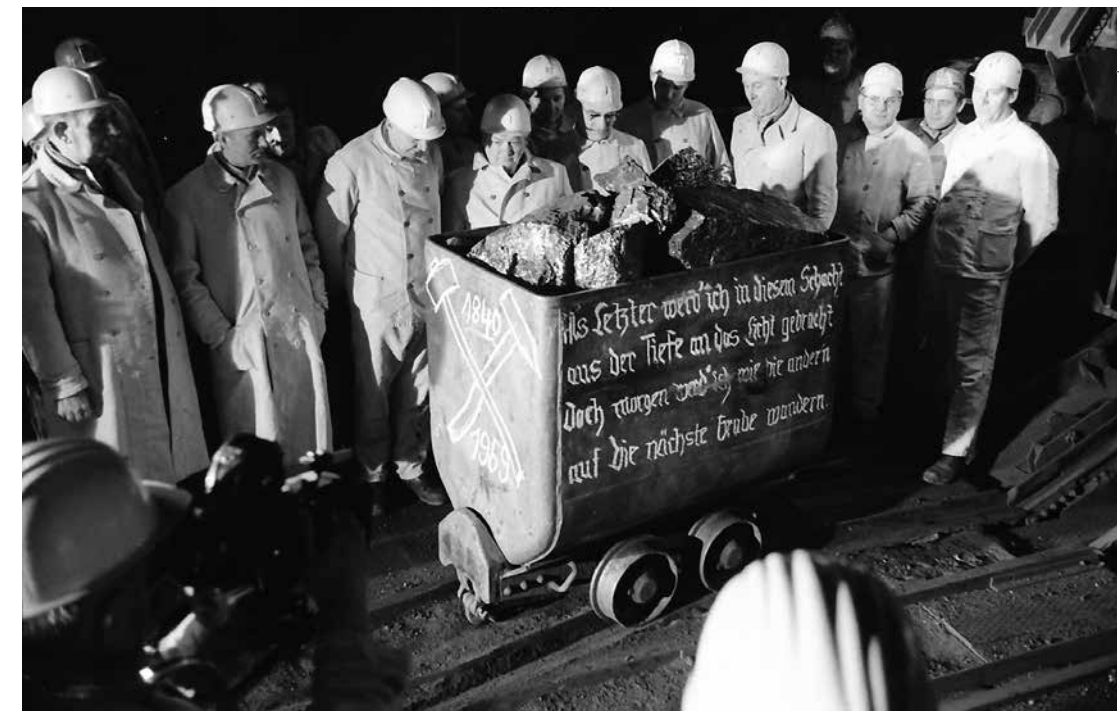
Abbildung 62 31. März 1969: Der letzte Förderwagen der Grube Gouley kommt zu Tage. Ganz links sieht man den Bürgermeister Fritz Severin Pütz, der selbst als Bergmann in dieser Grube beschäftigt war. (Kulturarchiv Würselen).
