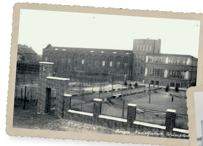
Foto der früheren Zigarrenfabrik Zimmermann aus dem Jahr 1935, das aber sehr gut die verschiedenen Bauabschnitte zeigt: „Zunächst wurde 1902-1903 [...] das Fabrikgebäude der ehemaligen Zigarrenfabrik Winand Zimmermann errichtet (giebelständig, drei straßenseitige Achsen, fünfschichtige Traufseite). Dieser Bau erhielt 1914 eine eingeschossige Erweiterung der Rückseite. Nachdem die Zigarrenfabrik in den Besitz von Peter Hartmann übergegangen war, beantragte dieser 1920 einen Anbau an der fünfschichtigen nördlichen Traufwand des Hauptfabrikgebäudes, der als zweigeschossiger Anbau samt einem kleinen zusätzlichen Gebäude an der westlichen Außenwand des Anbaus ausgeführt wurde.“ 52 (Foto Kulturarchiv Würselen)
