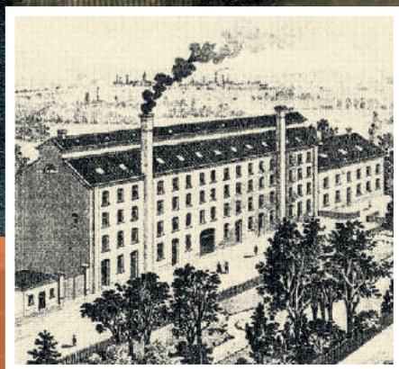
DIE ERSTE CIGARRENFABRIK IN WÜRSELEN
